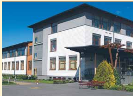
Budowa gimnazjum z halą sportową w Stanisławowie Pierwszym (2003–2006) – budynek gimnazjum
