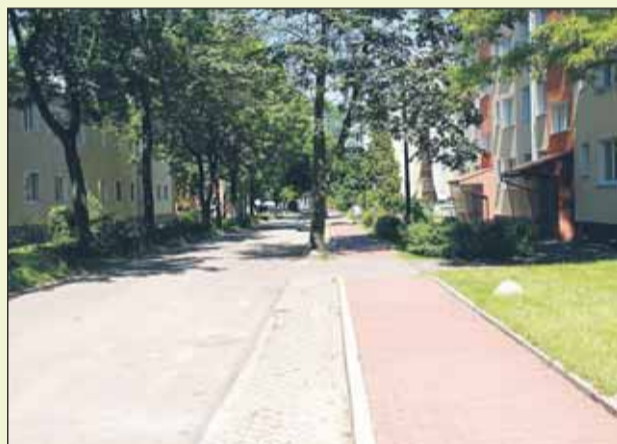
Drogi i chodniki na osiedlu w Zegrze Południowym (2007)
