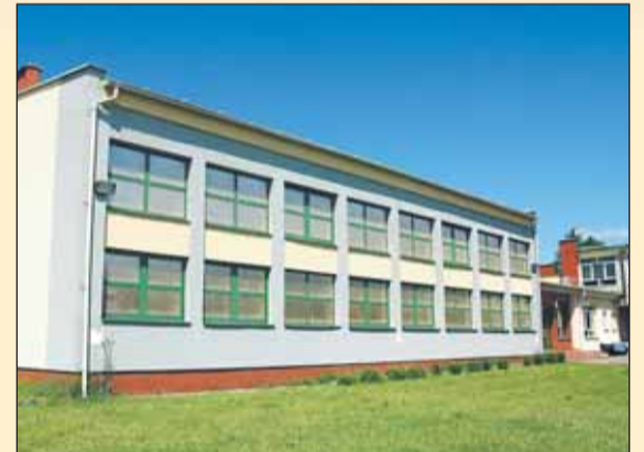
Budowa sali gimnastycznej przy Szkole Podstawowej w Wólce Radzywińskiej (2000–2002)
