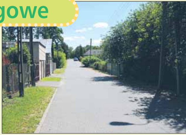
Ulica Wzgórz w Zegrze Południowym – nawierzchnia z kostki (2006)
