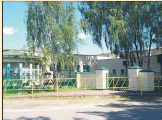
Budowa szkoły Podstawowej w Józefowie (1994–1998)
