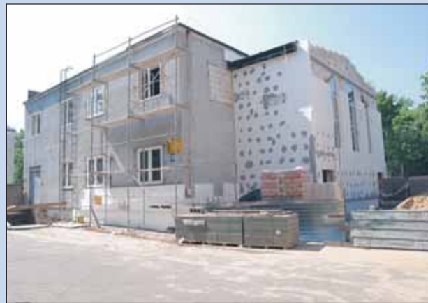
Modernizacja budynku komunalnego w Zegrzu Południowym na cele Ośrodka Kultury i Ośrodka Zdrowia (2010-2011)
