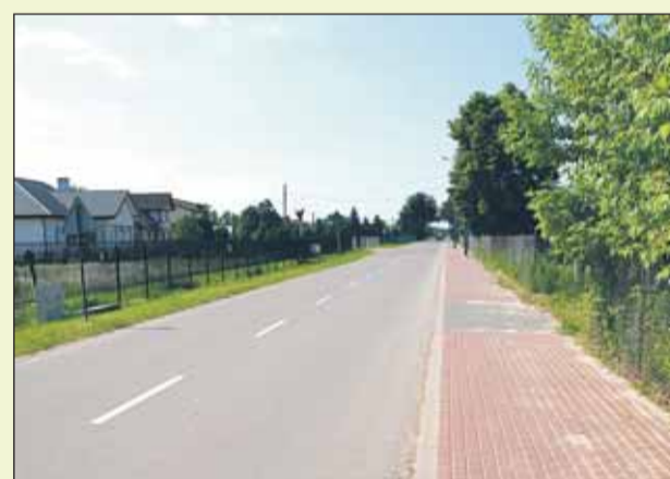
Ulica Przyszłość w Stanisławowie Pierwszym – budowa chodnika we współpracy z powiatem (2005)
