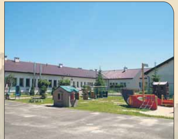
Budowa Przedszkola w Nieporęciu (1990–1991)
