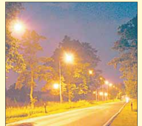
Oświetlenie ulicy Strużańskiej w Józefowie (2006)
