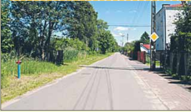
Asfalt na ulicy Rybaki w Zegrze Południowym (2006–2009)
