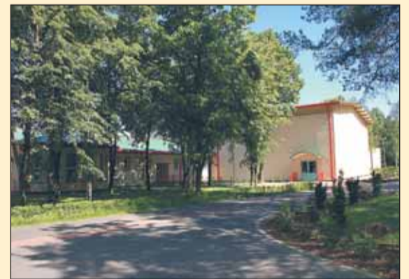
Budowa sali gimnastycznej z łącznikiem przy szkole Podstawowej w Józefowie (2007–2008)
