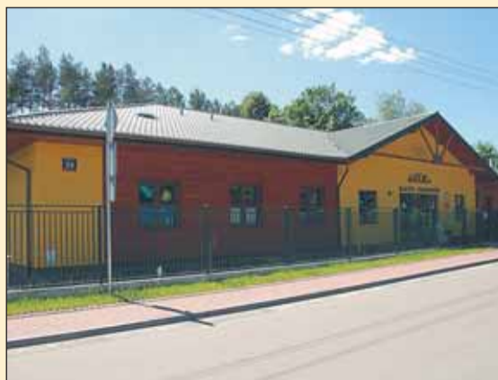
Budowa Przedszkola Gminnego w Zegrzu Południowym (2008–2009)
