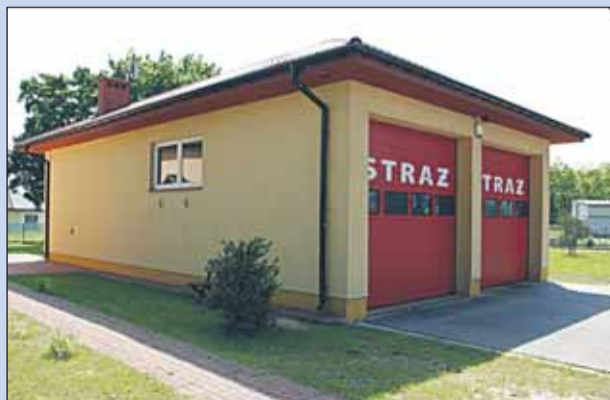
Budowa garażu dla OSP w Kątach Węgierskich (2006)
