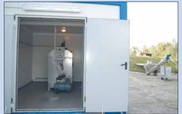
Modernizacja oczyszczalni ścieków w Nieporęciu (2008)
