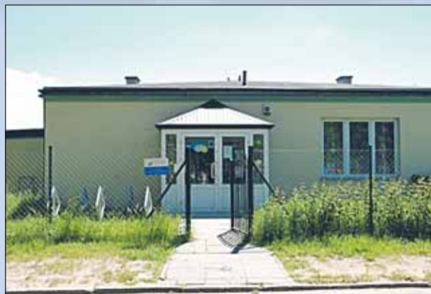
Budowa budynku Ośrodka Kultury (TPD) w Ryni (2000)
