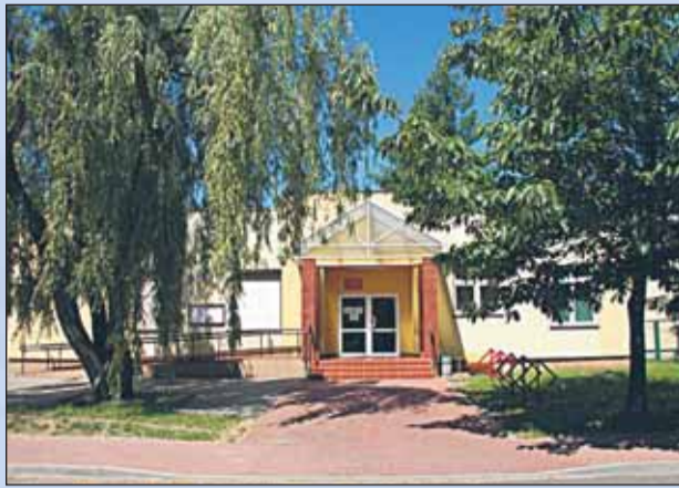
Budowa budynku Gminnego Ośrodka Pomocy Społecznej w Nieporęciu (2006-2007)
