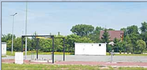
Pompownia P8 w Nieporęciu (2007)
