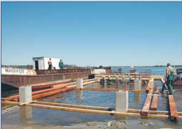
Budowa mola na Dzikiej Plaży w Nieporęciu (2010)
