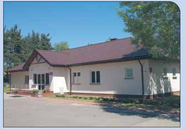
Budowa budynku Gminnego Zakładu Komunalnego w Nieporęciu (2007)
