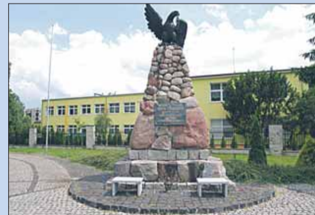
Budowa pomnika w Białobrzegach (2002–2003)
