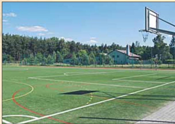
Budowa boiska o sztucznej nawierzchni przy gimnazjum w Stanisławowie Pierwszym (2007)
