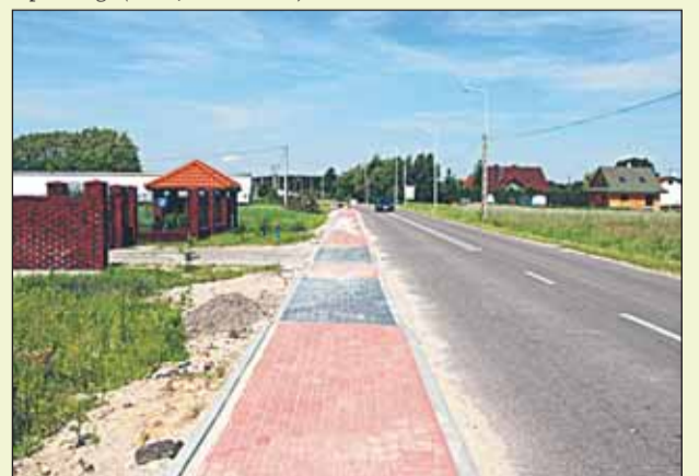
Budowa chodnika wzdłuż ulicy Akacjowej w Kątach Węgierskich (2010)
