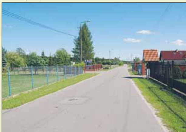
Nawierzchnia asfaltowa ulicy Przyleśnej w Kątach Węgierskich (2006–2008)
