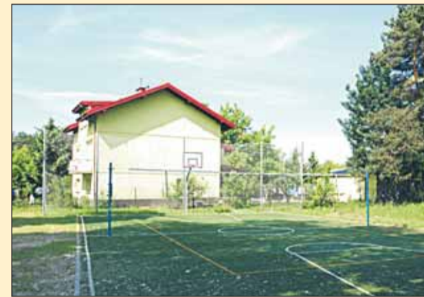
Budowa boiska o sztucznej nawierzchni w Benjaminowie przy filii GOK (2008)
