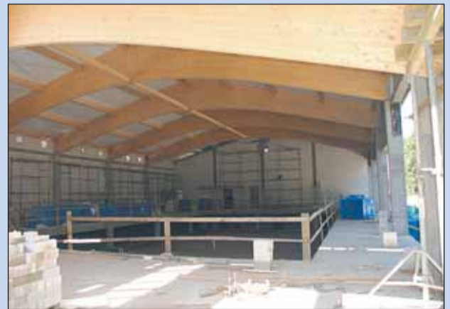
Budowa pływalni w Stanisławowie Pierwszym (2009-2011)
