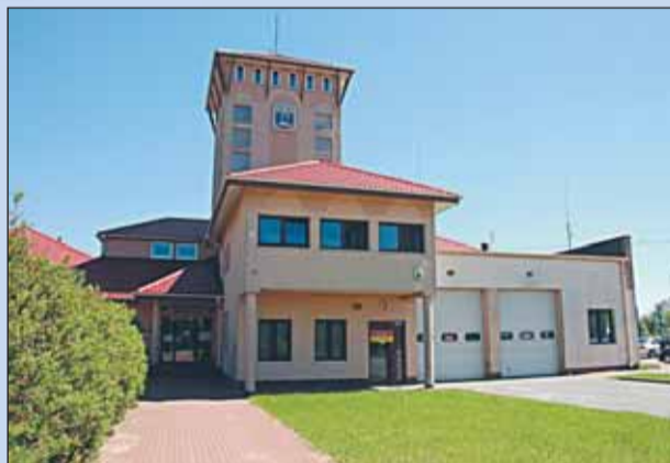
Budowa Stacji Strażackiej – Gminnego Ośrodka Kultury i siedziby OSP w Nieporęcie (1999–2002)
