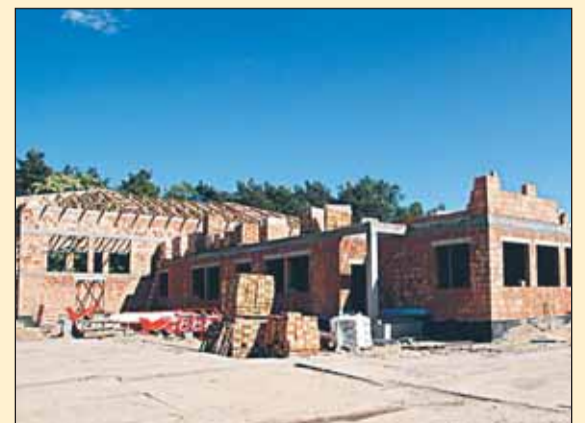
Rozpoczęcie budowy nowej szkoły podstawowej w Izabelinie (2009–2011)
