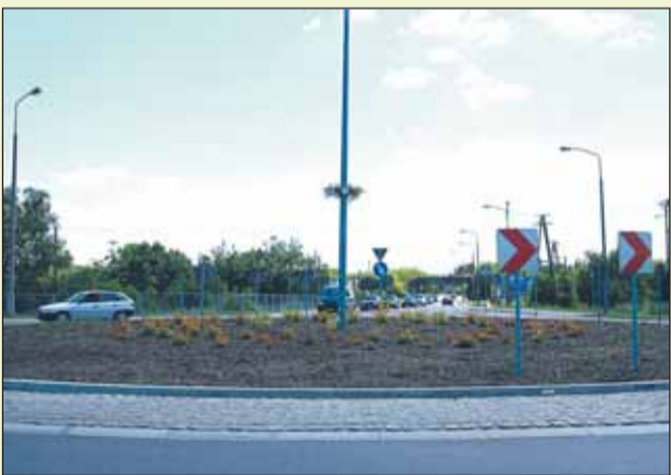
Budowa ronda w Nieporęcie we współpracy z MZDW (2008)
