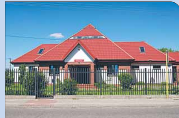
Budowa Domu Kultury w Stanisławowie Drugim (1996–1998)
